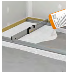
3 Pour and level fermacell™ levelling compound
